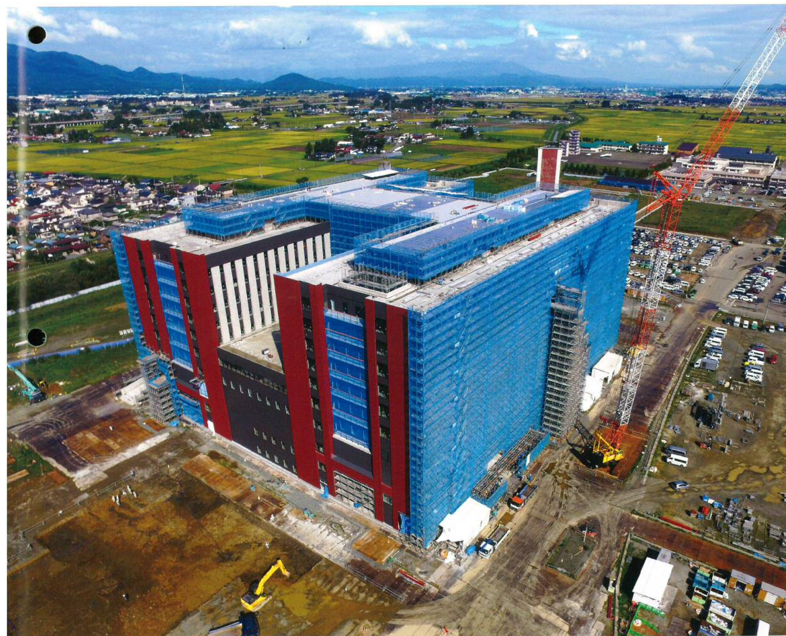
創立 120 周年記念事業 矢巾新病院建築工事進捗状況（平成 30 年 9 月 11 日撮影） 7 月末上棟、9 月現在南側足場解体、10 月中には病院全景が現れる予定。
