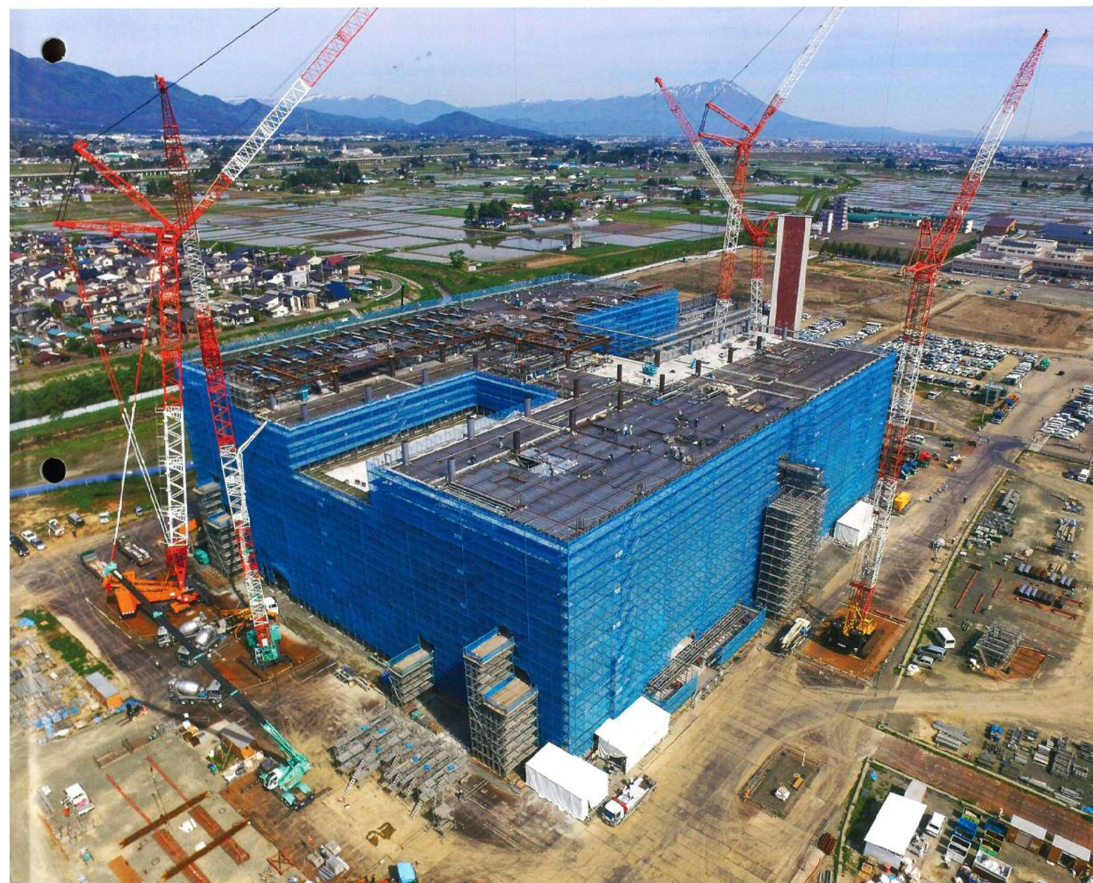
創立 120 周年記念事業 矢巾新病院建築工事進捗状況 (平成 30 年 5 月 22 日撮影、9 階まで進行)
