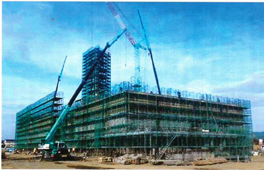
矢巾キャンパス附属病院移転敷地において建設が進む エネルギーセンター (平成27年10月28日撮影)
